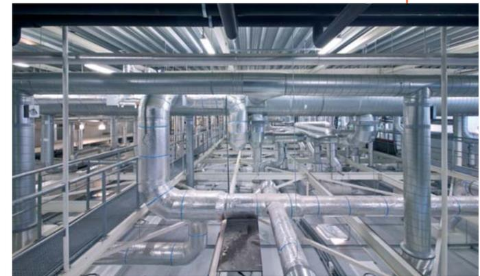
Leckagen, falsche Leitungsdimensionen und über Jahre geänderte Kanäle führen zu einem sehr energieaufwändigen Transport der konditionierten Luft hin zum Bestimmungsort. Die Optimierung des Luftführungssystems hat immer positive Auswirkungen auf den Betrieb der kompletten Lüftungsanlage.
